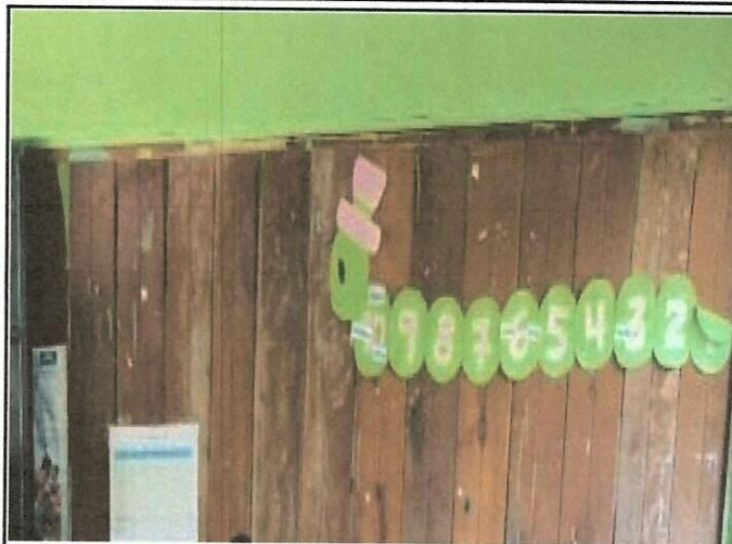
Foto 2: SUSTITUCIÓN DE PARED E TABLAS POR PARED DE BLOCK DIVISORIA DE AULA
