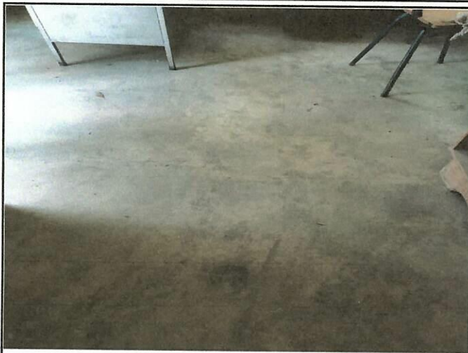
Foto1: MEJORAMIENTO Y SUSTITUCIÓN DE PISO AULA PÁRVULOS, DIRECCIÓN Y COCINA
