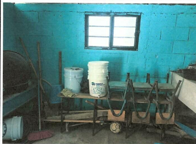
Foto 5: CONSTRUCCIÓN DE GABINETE ÁREA DE COCINA CON BLOCK Y AZULEJO No1
